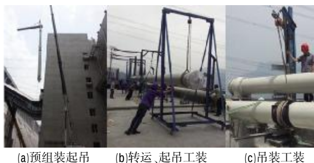
图 13 不同的吊装形式及专用工装
